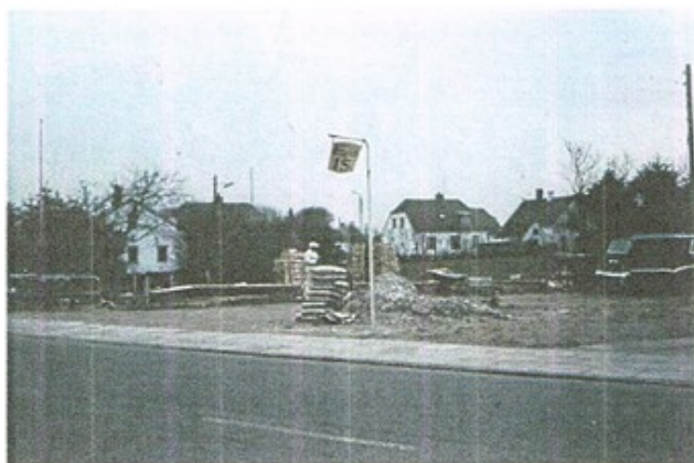
Ventesalen under opførelse i 1967.
